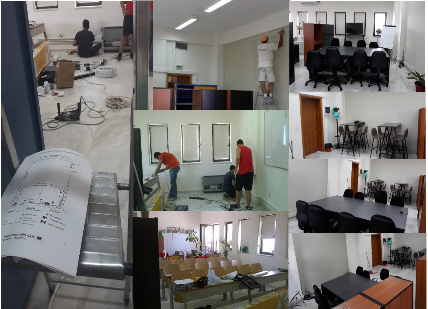
Εικόνα 1 Στιγμιότυπα από τις εργασίες διαμόρφωσης του Oli_HUB και όψεις του τελικά διαμορφωμένου χώρου
